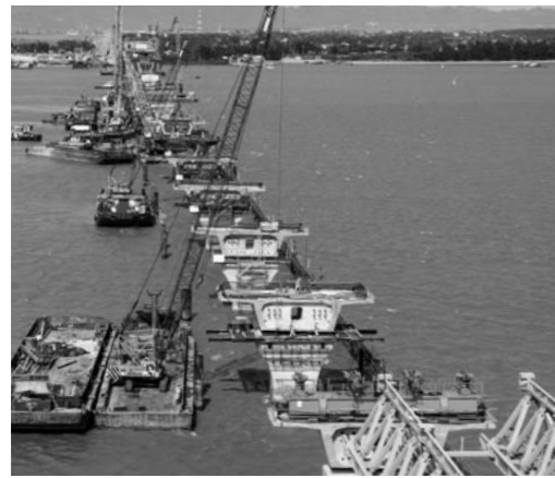
海上部の架設作業が本格化するライン2。下部工と、プレキャスト柱頭部据え付けと現場打ち横桁は完成間近。
