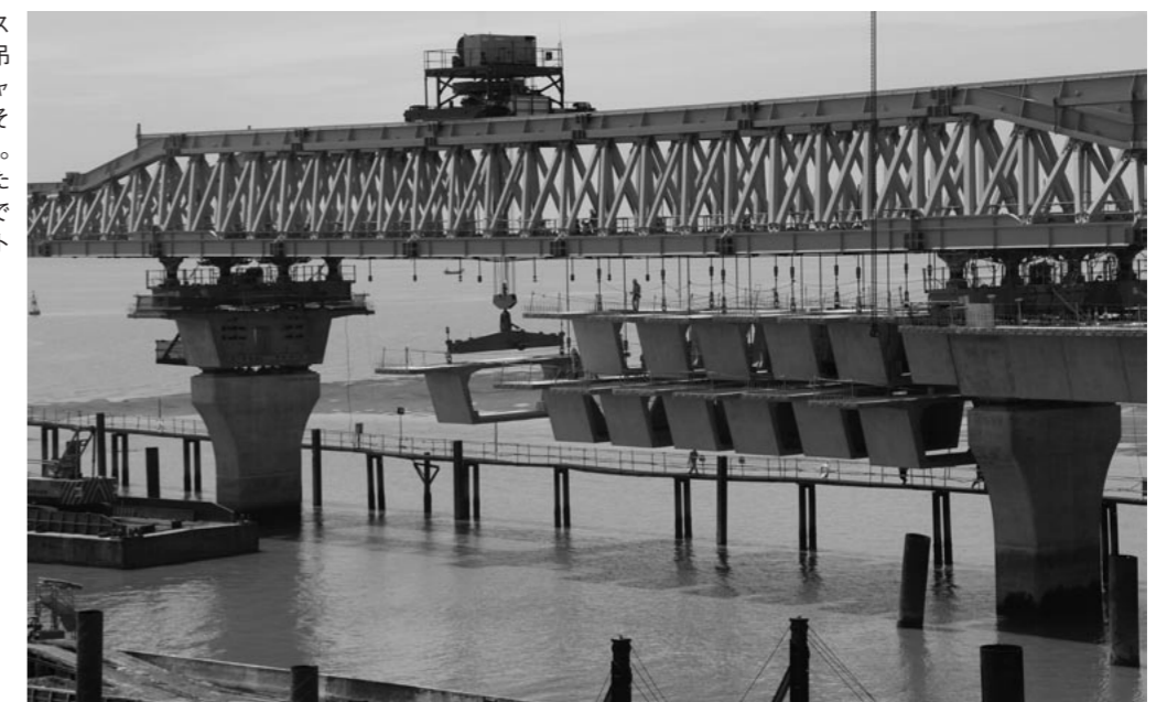
超大型スパンバイスパン鋼製架設桁で吊上げられたプレキャストセグメント。その重さは約80トン。海上部では完成した橋上をトレーラーで運搬してセグメントを供給する。
