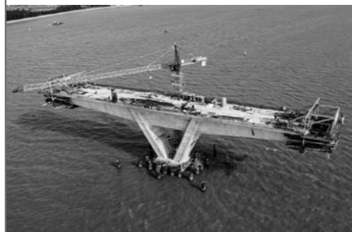
今では水中に隠れて見えなくなった鋼管矢板基礎に支えられ主橋上部工の施工が進む。
