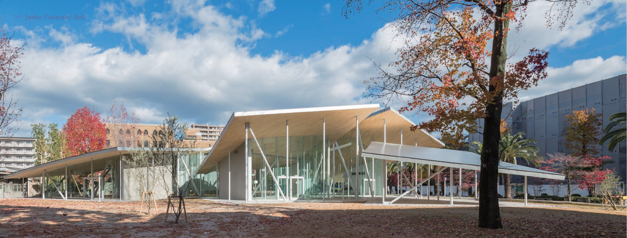
南側より見る
