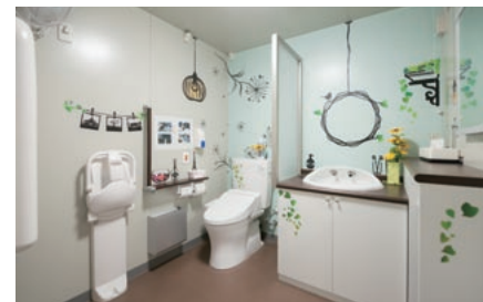
2016年4月号の「輝け！けんせつ小町」で紹介した、現場事務所の女性用トイレ。このようなトイレを設ける取組みも広がりを見せている。
