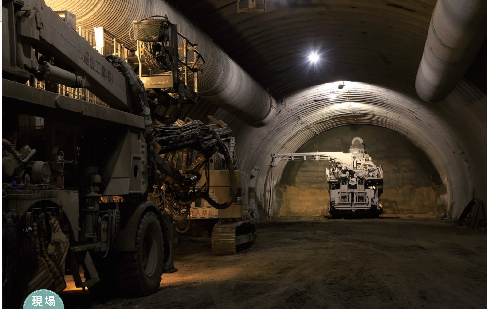
掘削完了したところからアーチ型の鋼製支保工を設置し、コンクリートを吹き付ける。その後、左手に見えるドリルジャンボで6mの穿孔を実施し、ロックボルトを放射状に打ち込み、地盤と一体化させる。
