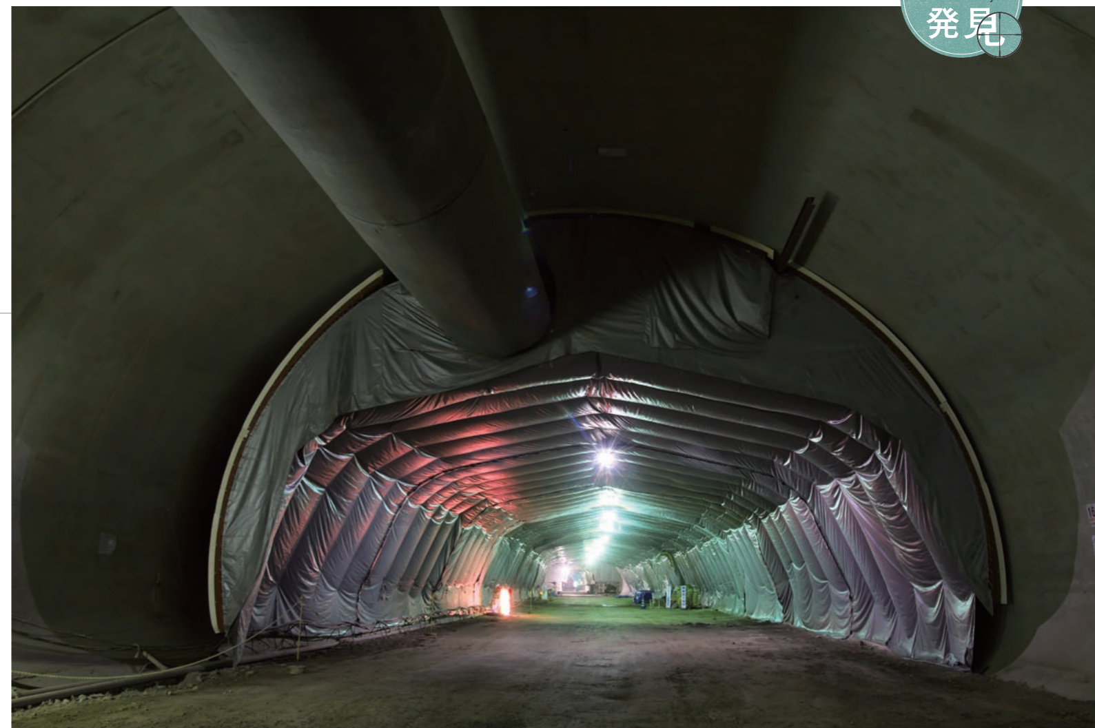
一連の掘削から覆工の構築が済むと、表面をシートで養生し、打設した覆工コンクリートの耐久性を向上させる。坑内の通路も粉塵の飛散を防ぐため清掃を欠かさない。
