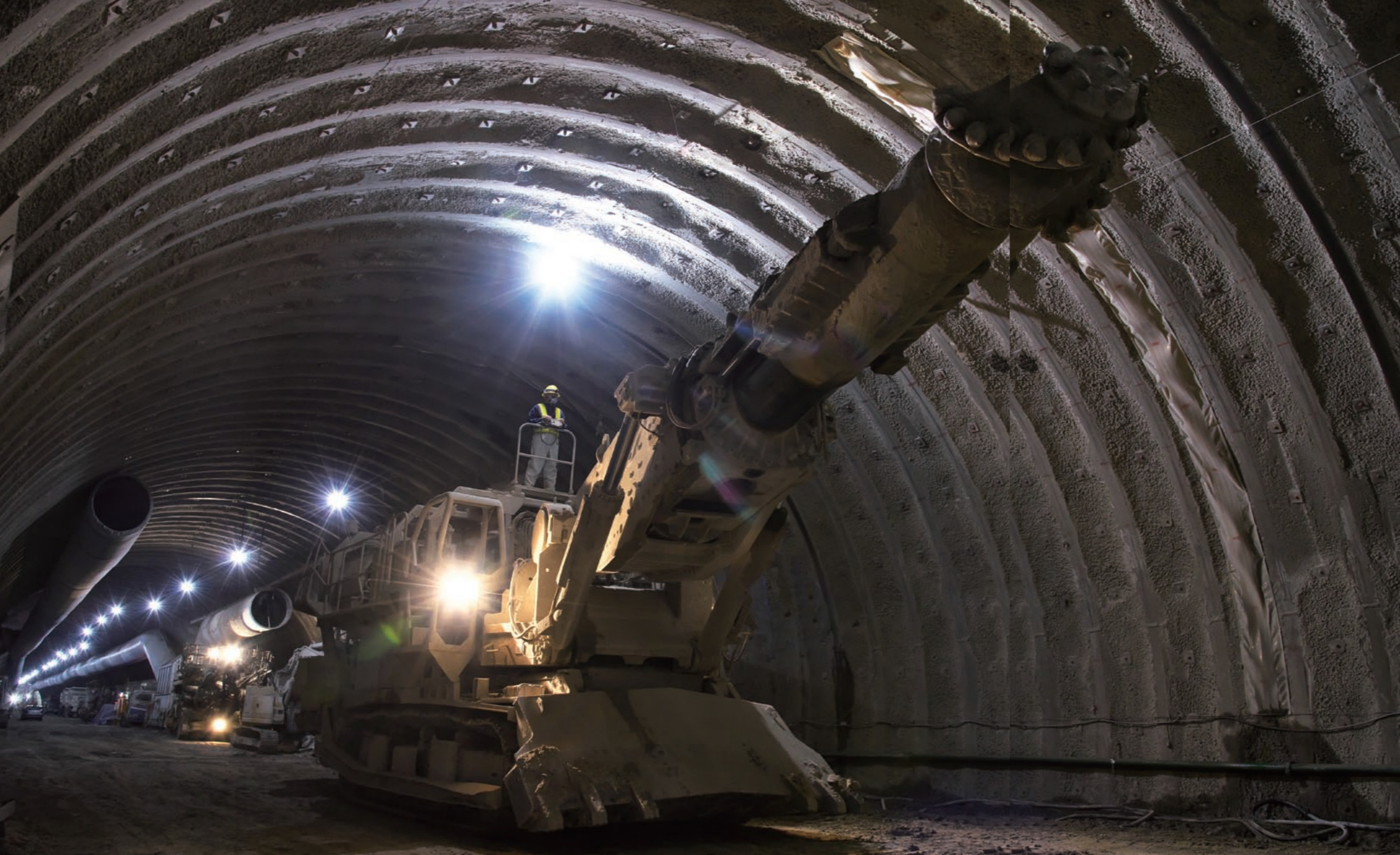
トンネルは自由断面掘削機で地山を削り、掘り進められる。現場周辺への環境に配慮し、火薬を使った発破は用いていない。
