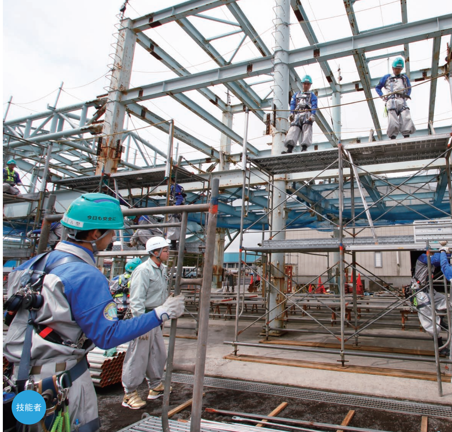
屋外では足場の組立て実習が行われていた。安全かつ作業しやすい足場を組むための実践型の教育だ。
