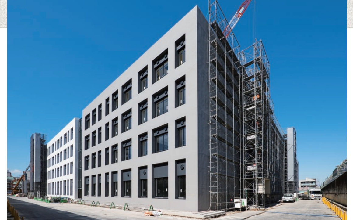
4階建ての新校舎。今年3月には南側の外観の美しいデザインが姿を現した。
