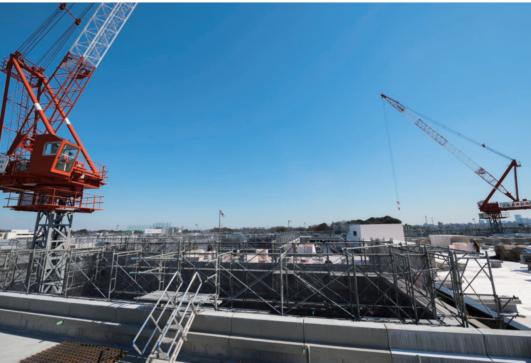
昨年12月に上棟し、今年1月末に4基のタワークレーンのうち2基を解体。南東と北西の中庭の2基で段階的に工事を進める。
