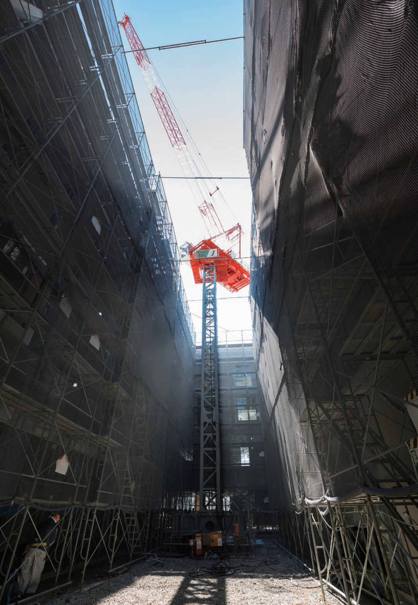
口の字型に囲まれた中庭に4基のタワークレーンが据えられ、資材の揚重や建設工事にパワーを発揮した。
