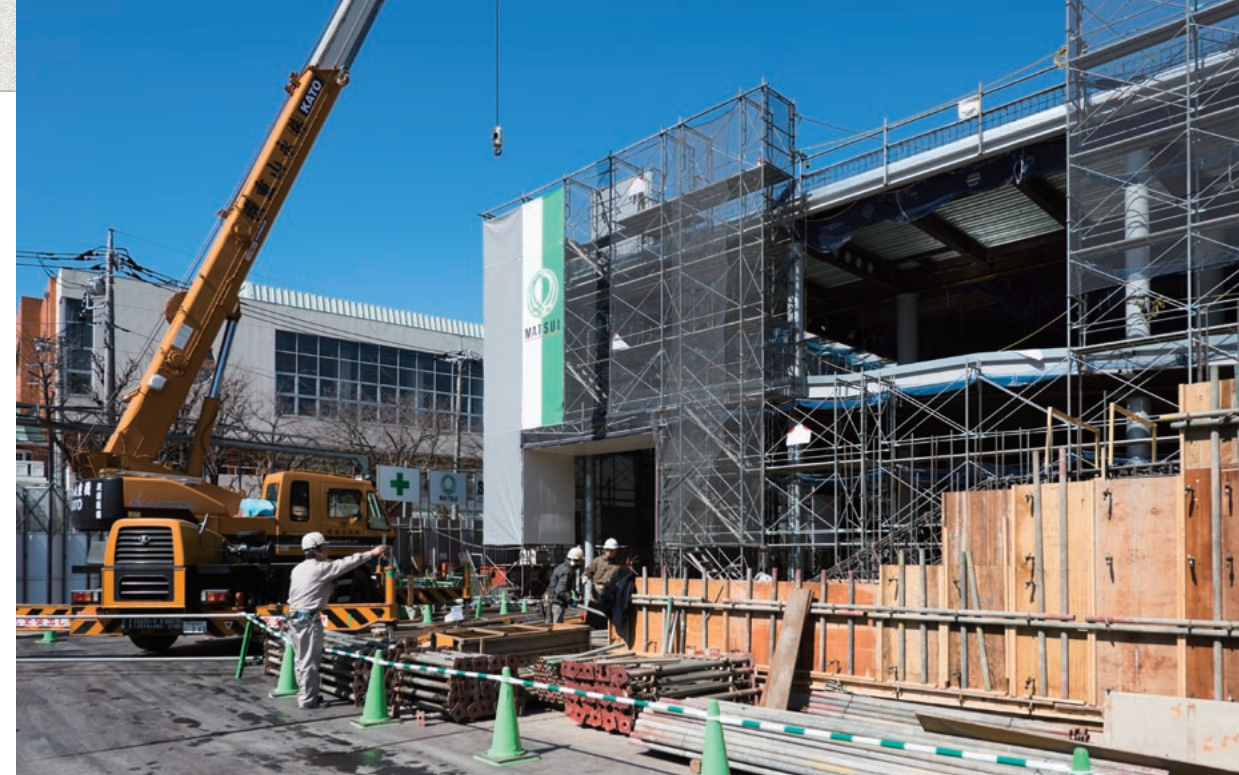
最後の工程で教室棟の西側に接続する400席の講堂と昇降口に着手。大階段のコンクリート打設工事が進む。
