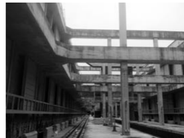
緊急救出待避線より地上を撮影
