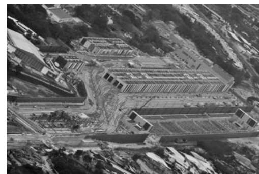
手前：緊急救出待避線 中段：車両基地（8線分）修理用車庫（4線分） 上段および右部：各種管理棟
