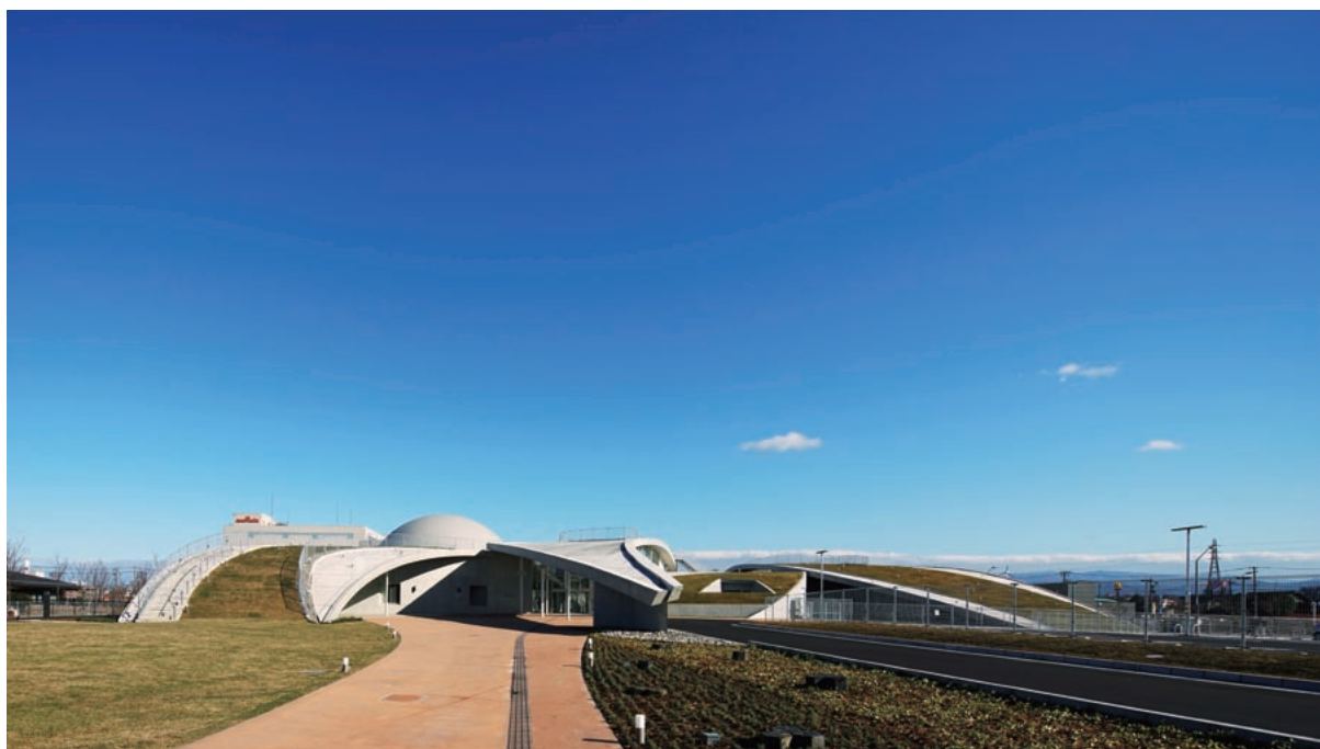
西側外観。緩やかな曲面の屋上はさまざまな草花と散策のための遊歩道が整備され、多世代の市民が楽しめる。この緑化された屋根は断熱性能を高め、庇となって日差しを制御しているほか、雨水の貯留槽としても機能する。
