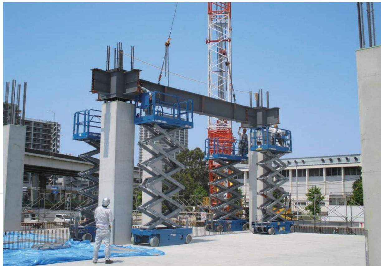
FSRPC-B構法の施工時の様子。ユニット化した梁を取り付けている(提供: ㈱フジタ)。
