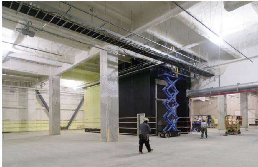
高所作業用リフトを使って天井の断熱材が吹き付けられた、定温庫の様子。
