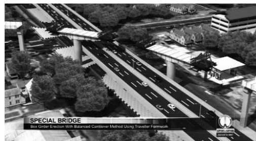
長大橋部 バランスカンチレバー工法
