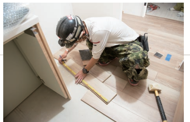
上／クロス貼りの様子。素早く、かつ丁寧に作業が進む。 下／その場で調整を行いながら、床材を並べていく。
