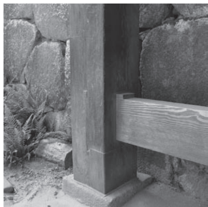
尻挟み継ぎによる根継
