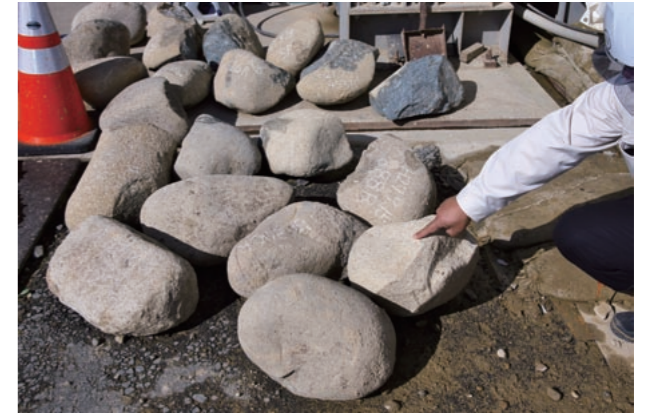
太古の川の流に洗われたのか、巨大なラグビーボールのように丸みを帯びた玉石。人力で移動することは容易ではない大きさだ。これら40cm級の玉石はそのままリボンスクリューによって排出された。
