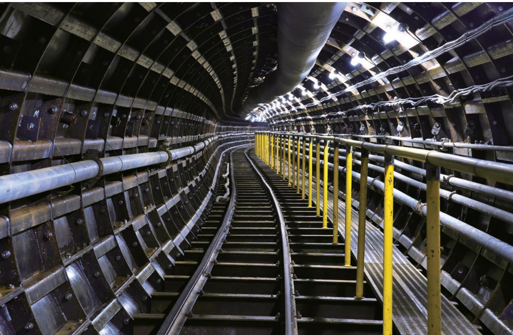
順調な時は昼夜で計画通りに掘り進めることができるが、地盤が変化するとマシンが突然止まってしまう。着工したての頃は計画の半分も掘進できなかったことがあった。
