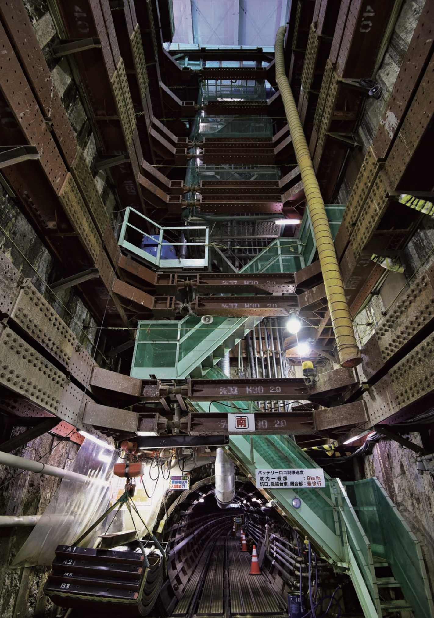
発進立坑からトンネルを掘進、新たにA管を布設する。ここから700mほどの区間は住宅エリアだ。施工音は大きくはないがゴロゴロと雷のような音が響く懸念があったため、騒音と振動に配慮し変則シフトで深夜の施工を中止した。
