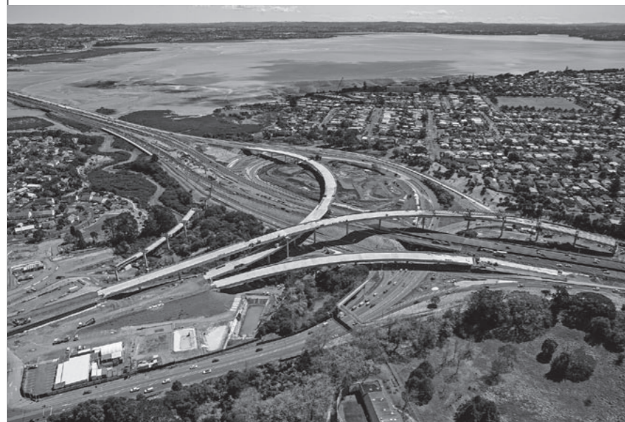
建設中のインターチェンジ(既設高速道路との合流)
