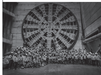
2本目トンネルの貫通(南坑口)
