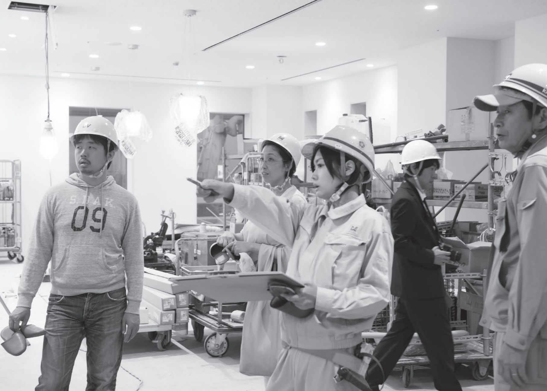
これまでも病院関係者を対象に月1回現場見学会を行っていた。引き渡しが近づき、多い日は1日に5回病院関係者の案内をする。
