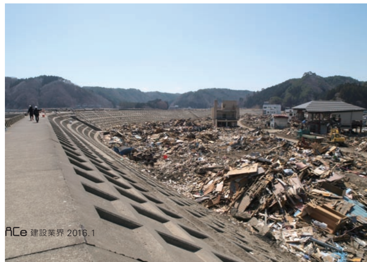
2011年4月10日の田老地区。津波は防潮堤を乗り越え、市街地を呑み込んだ。
