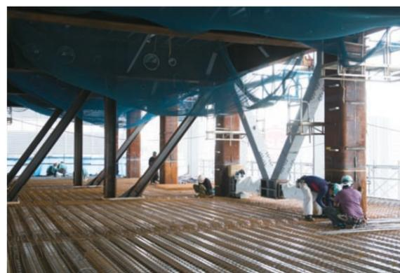
床配筋の様子。この現場では制震壁や制震ブレースもデザインの一部になっている。
