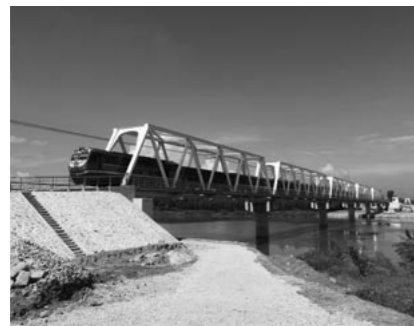
Tra Bong Bridge 施工後
