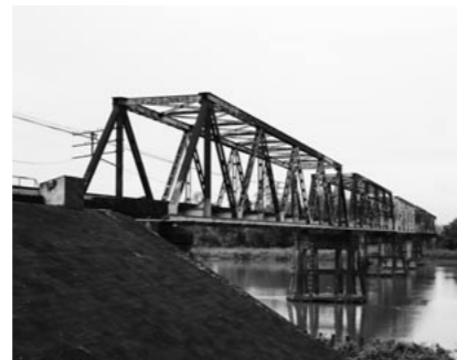
Tra Bong Bridge 施工前
