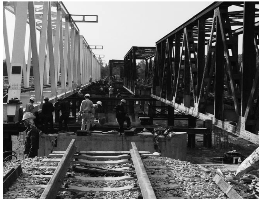
Tra Bong Bridge 施工中
