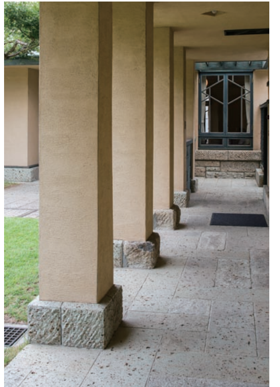
東教室側の廻廊。床面や柱の土台には大谷石が使用されている。ライトは同時期に取りかかっていた帝国ホテルに使用するために大谷石を選び、それが明日館にも多く用いられた。
