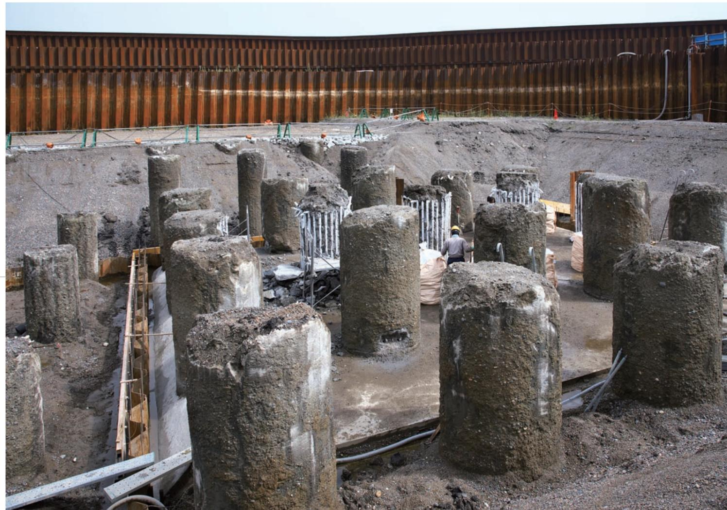
水門基礎部の施工が進む。水門の基礎杭となる場所打ち杭(オールケーシング工法による鉄筋コンクリート杭)が床付け掘削により露出している。
