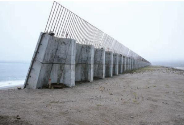
概成した防潮堤の上部工は今後着工する。防潮堤の背後は40m以上にわたって盛土し、引き波にも負けない防潮堤を構築する。
