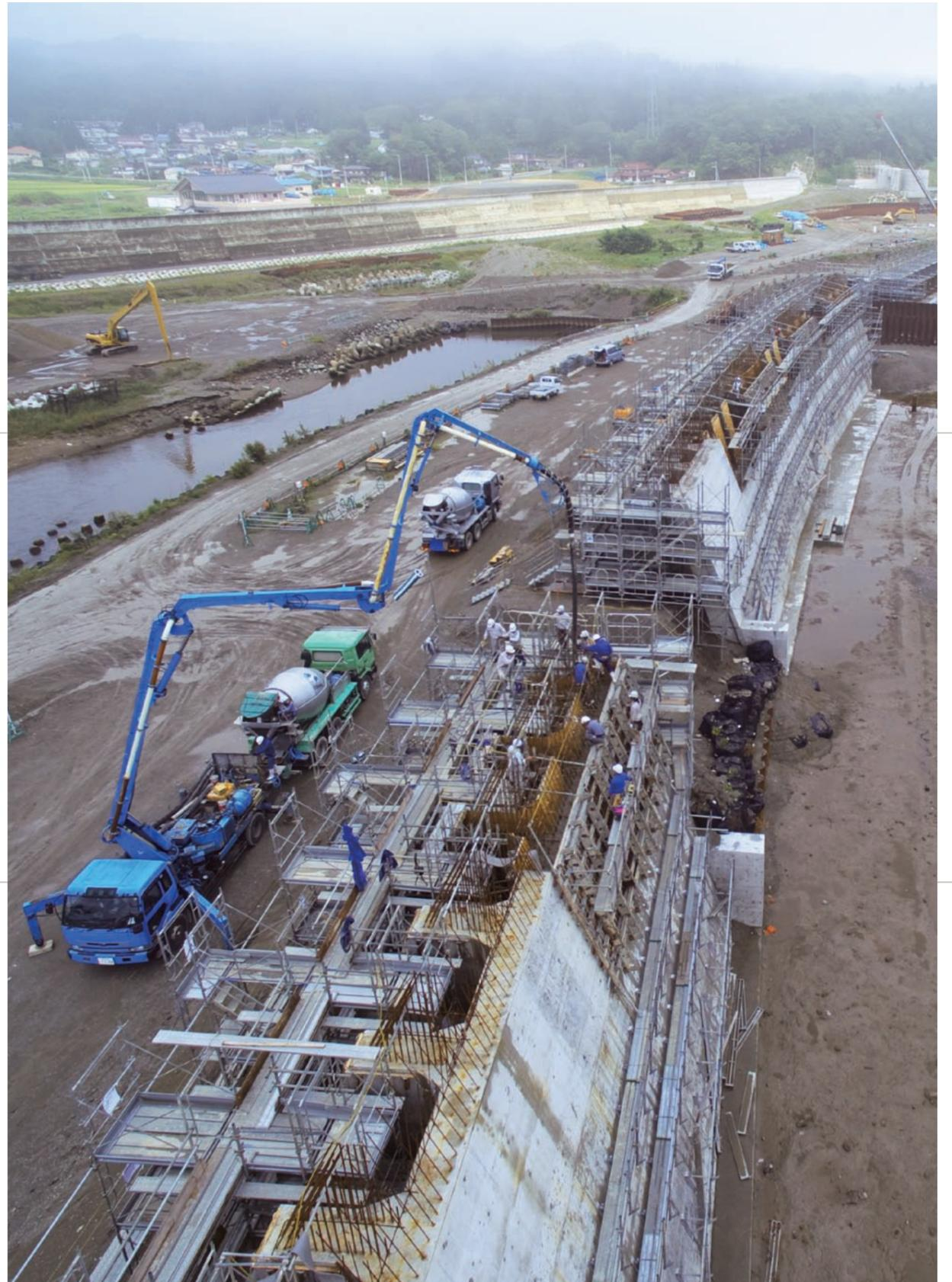
5段階に分けてコンクリートを打設し、逆T字型の堤体を築造。基礎部にはセメントミルクにて土壌を攪拌しながら建て込む鋼管ソイル杭を採用した。
