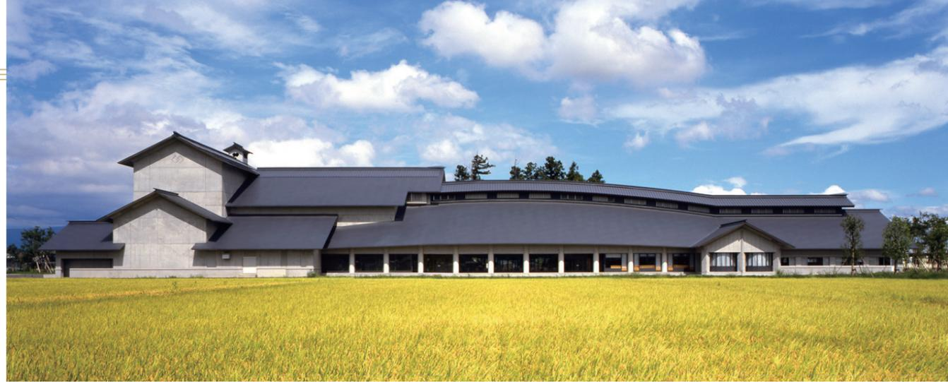
竣工当時の南側外観。建物の長さは127m。屋敷林をもつ民家の集落のイメージでデザインされている。冬に強い西風が吹くため、受け流すように、西側(写真左)に背の高い「劇場ホール」を配置して風を遮り、東側(写真右)のロビーと「図書館スペース」に向かって次第に小さく低くなっている。(撮影:木寺安彦)
