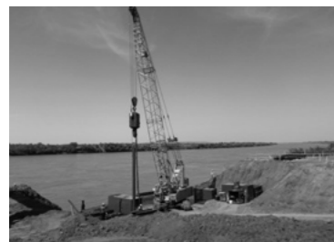
アリアブポンプ場での工事開始時のシートパイル打設
