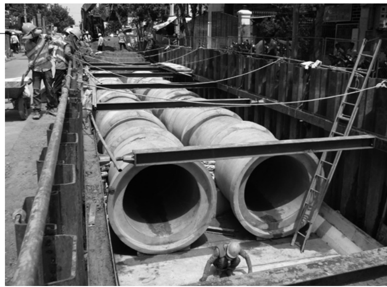
径1,500mm x 2連パイプ敷設状況 (432通り)
