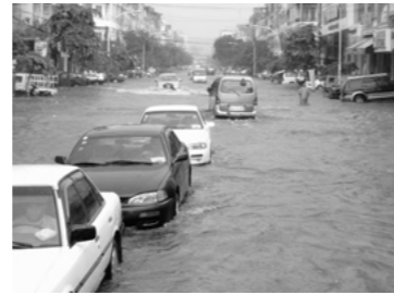
工事着手前の道路冠水状況 (217通り) 2010年4月撮影
