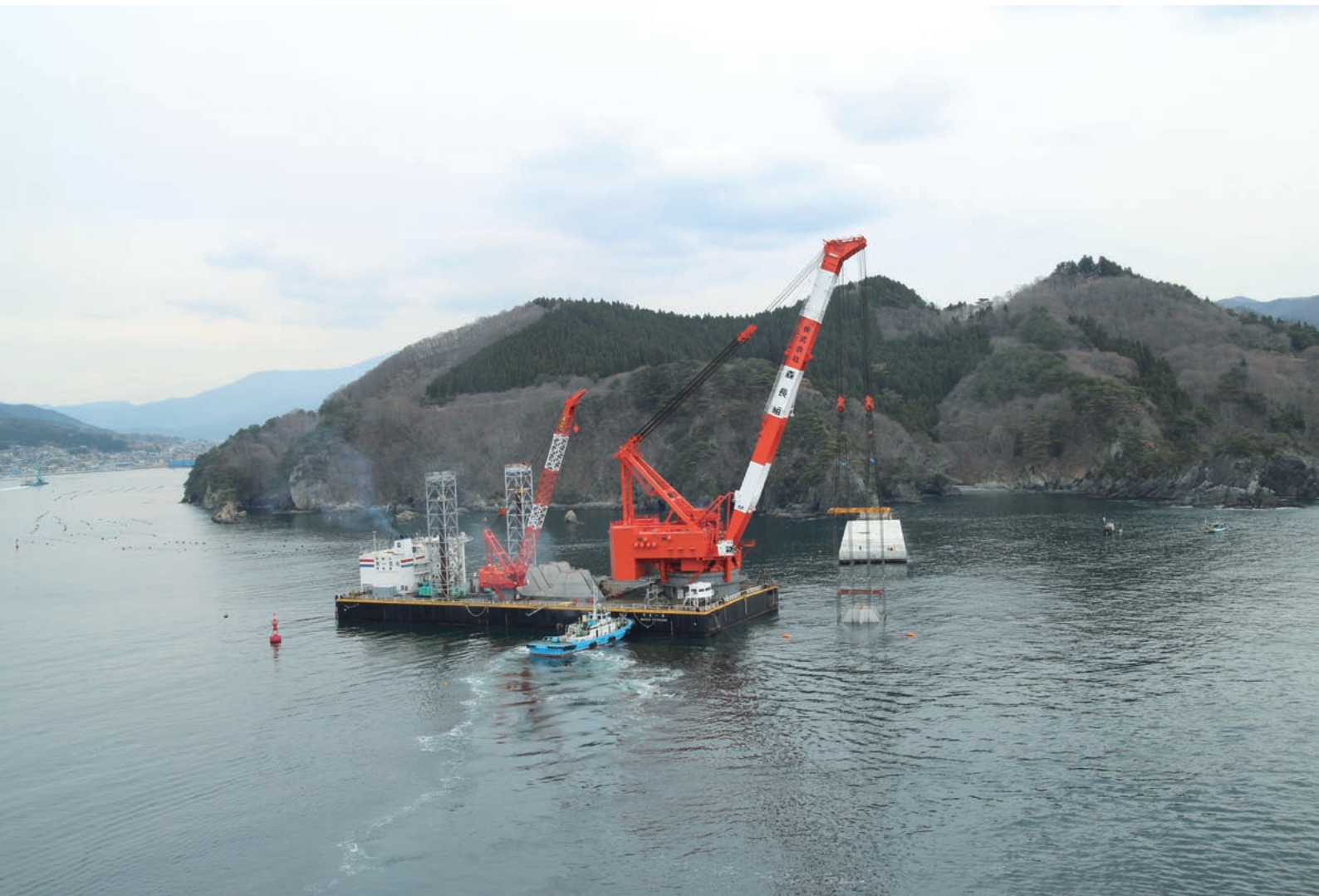
日本に2隻しかない長さ約110mの旋回式起重機船で逆T型ブロックを据付けた。(提供：東亜建設工業(株))
