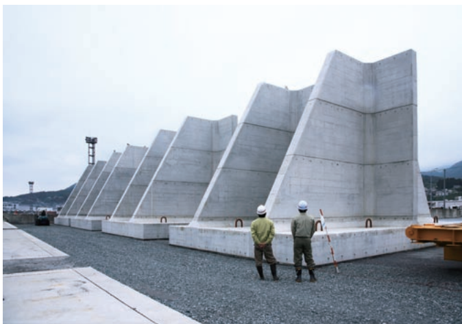
次工事で据付け予定の逆T型ブロック。高さ9mの潜堤が湾口部の海底で、港内に侵入する津波を抑える。
