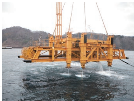
基礎捨石を、短い鉄がくし状に並んだ“レーキ”と転圧ローラが装備された機械で均していった。(提供：東亜建設工業(株))
