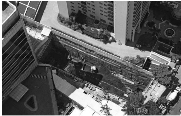
2014年1月。地下掘削状況 (GL-16m)。アースアンカー山留め工法。
