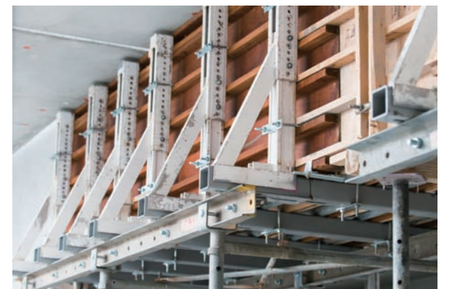
現場打ち梁のシステム型枠。
