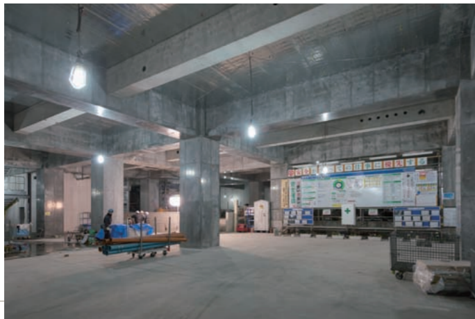
1階の様子。階高さは5mほど。PC梁と現場打ちの小梁が混在する。
