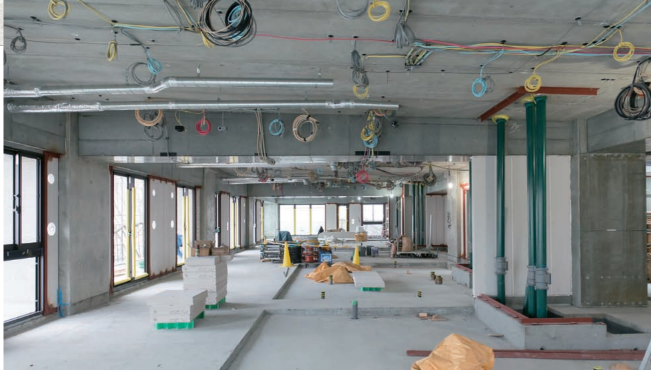
住居部分の様子。柱のスパンが約8.5mあるため、すっきりとした印象。スラブも斜めになっているのがわかる。
