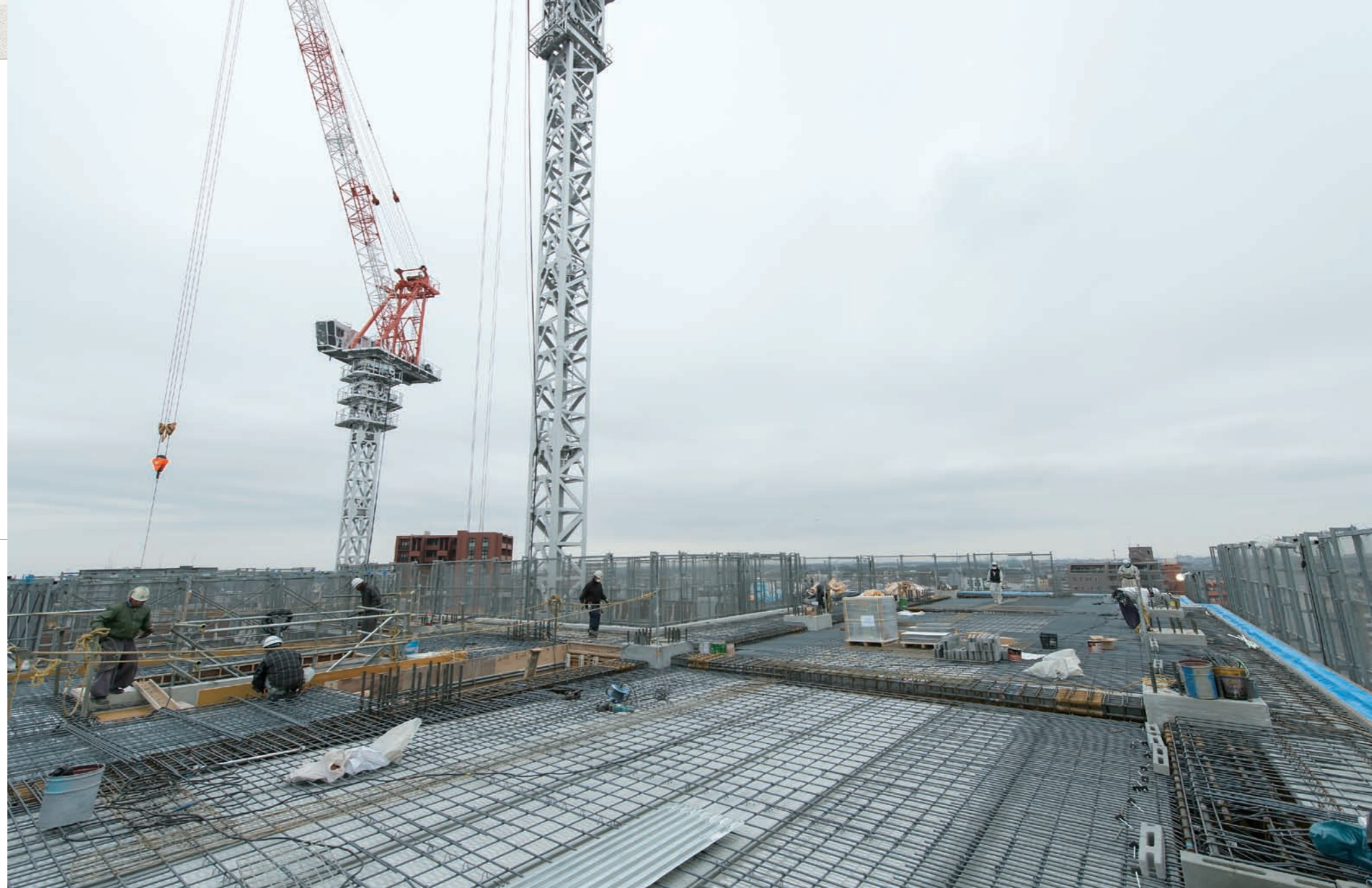
9階の配筋作業風景。写真中央に向かって、「スーパーフレックススラブ」の採用によって、配筋が斜めになっていくのがわかる。
