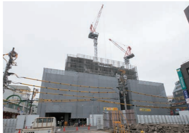
計画道路を跨いだ隣の敷地から建物を見る。自走式駐車場も同時に建設されている
