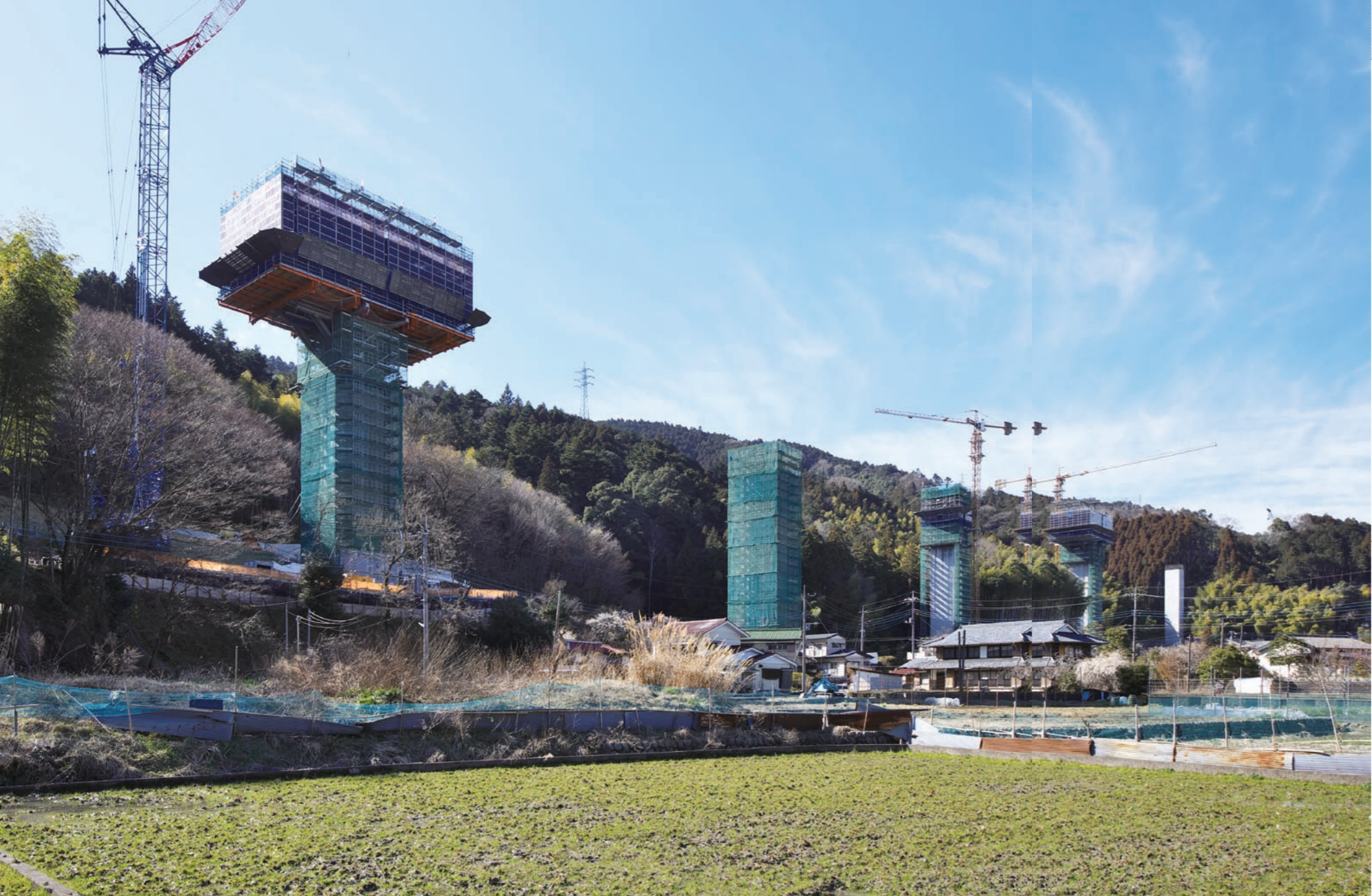
建設が進む平高架橋。その右手の尾根を超えた工区が大堀川橋だ。両橋あわせて橋脚を9基、橋台は3基施工する。施工区間は973m。2012年7月に着工し、今年9月の完工を目指している。
