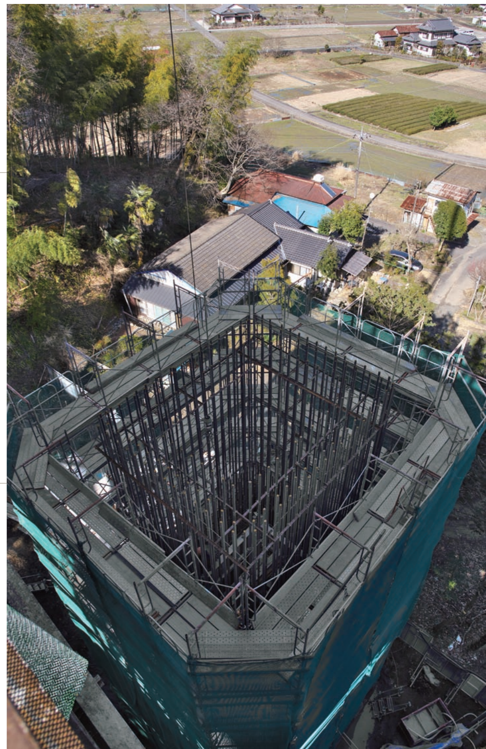
現場のすぐ近くに居住区が迫る。地域の環境保全は最重要課題だ。外足場の四方にメッシュシートで覆い、落下防止、粉塵の飛散抑制に万全を期した。
