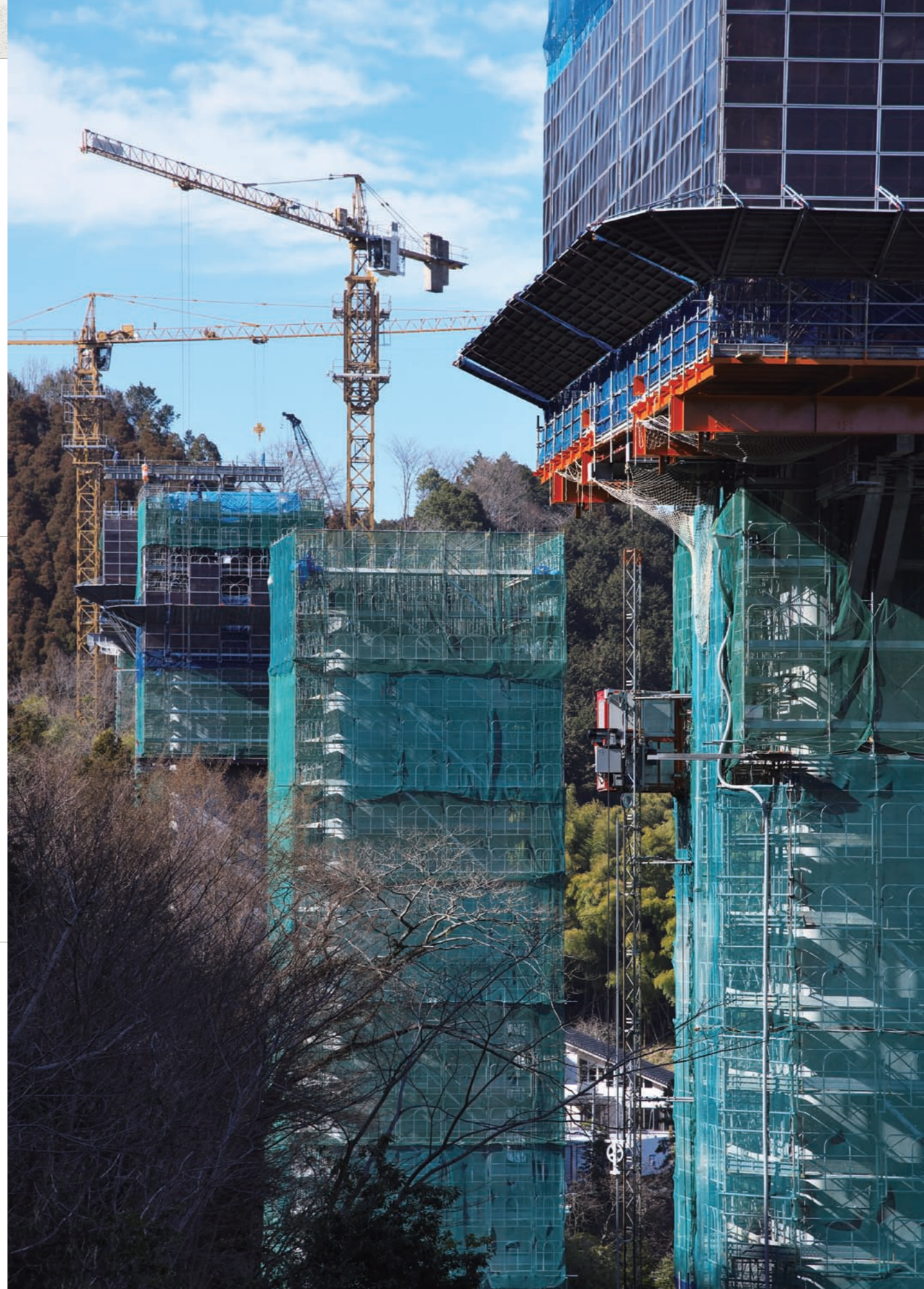
橋脚の建設にあたっては柱部外、内足場に自動昇降足場を採用し、落下防止エアバックを設置するなど、細部に渡り安全対策を施した。完工した橋脚から次工程に引き渡し、順次橋桁の施工が始まる。
