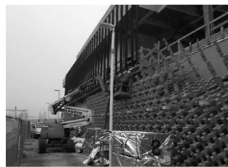
西面外装工事施工状況 (2014年12月時点)
