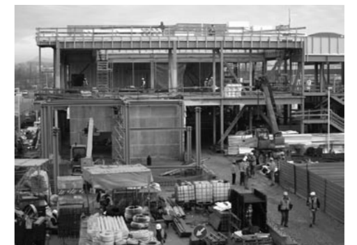
南面作業所全景 (2014年12月時点)
