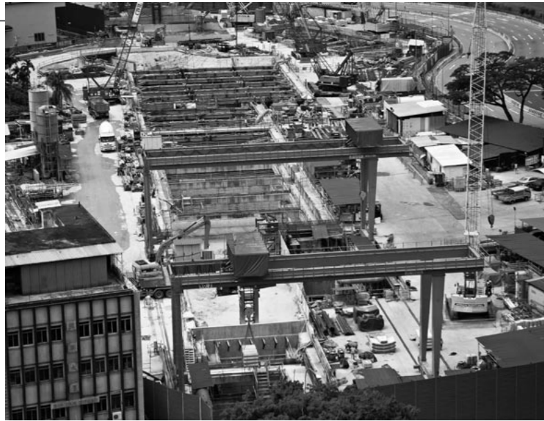
現場全景 (2014年6月撮影)
