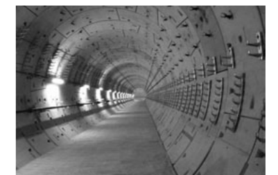
現在のトンネル状況
