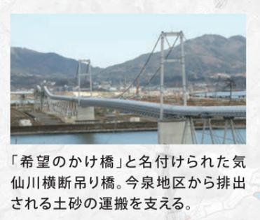
「希望のかけ橋」と名付けられた気仙川横断吊り橋。今泉地区から排出される土砂の運搬を支える。
