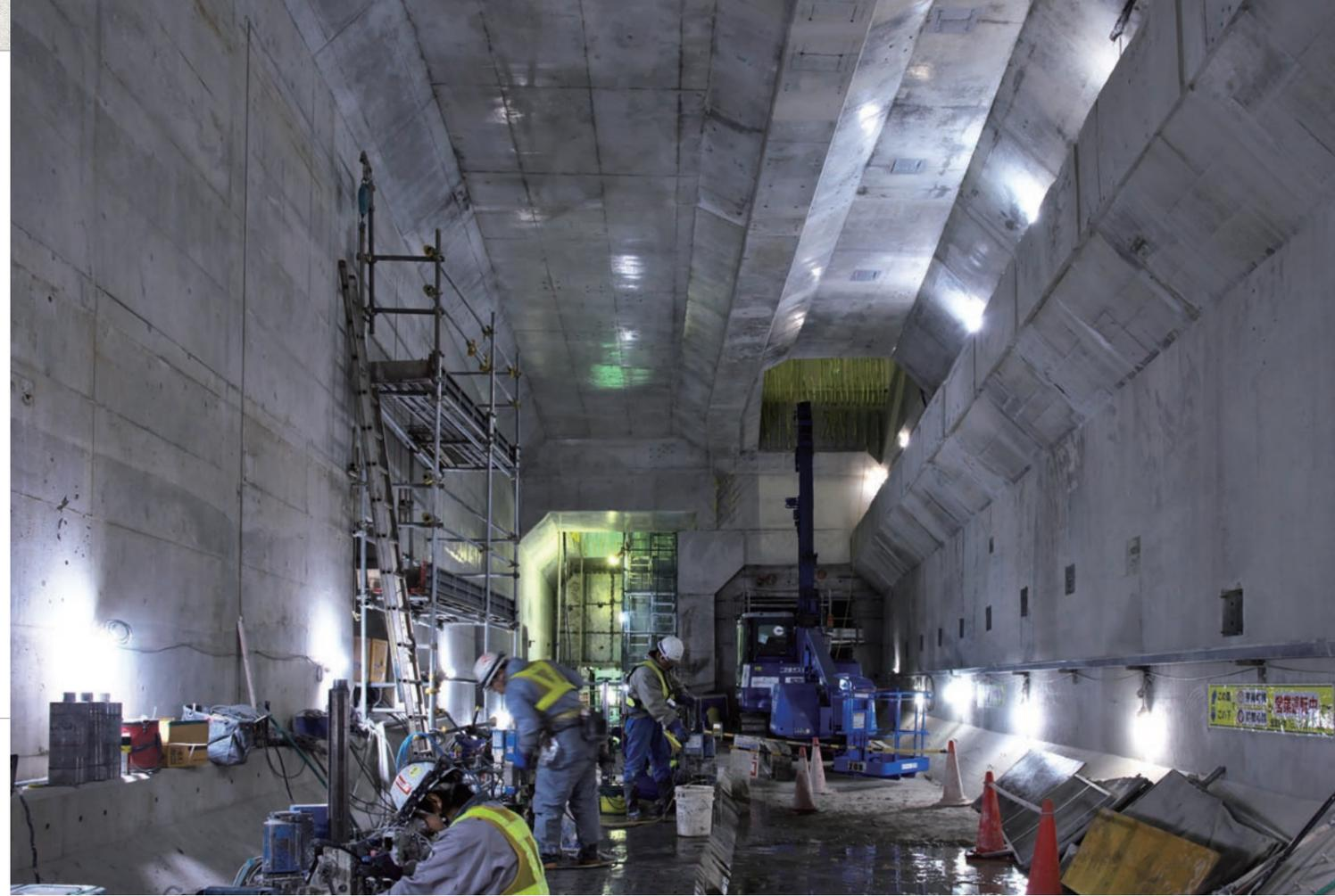
隣接する小竹向原方面の工区(左側)はシールド工法で連絡線を構築した。掘削はすでに完了している。これから線形を整え連絡線を開通させる。右の壁の向こうは有楽町線の営業線だ。
