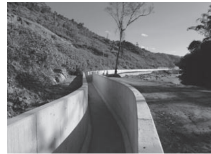
導水路(完成区間)
