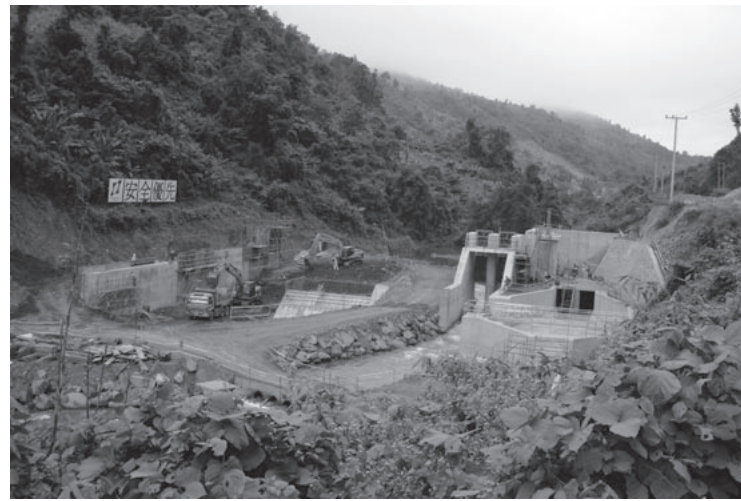
取水堰(左岸側を終え、右岸側を施工中)
