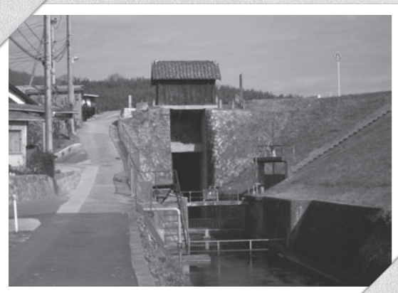
高瀬通しの一ノ口水門
