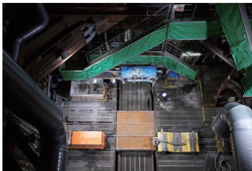
地下約20m、シールドマシンの発進ポイントに至る立坑。土留には特殊なソイルセメントを用いて連続壁を構築する、環境に優しいECO-MW工法が採用された。
