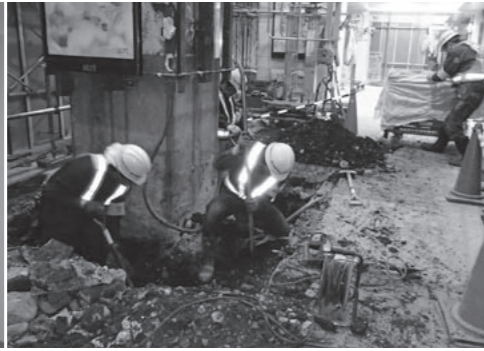
左/既存のコンクリート柱に鋼板を巻きつけて耐震化した。 「鋼板巻きっていうんですけど、これは今回の耐震工事で初めてやらせてもらって、面白いな、と」 右/柱の基礎を出す部分では、柱を傷つけないよう機械でなく人力で掘る。 深礎工の本来の職分はこの分野だ(提供:鉄建建設(株))。
