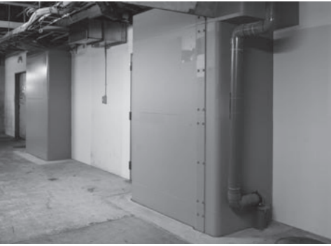
左/既存のコンクリート柱に鋼板を巻きつけて耐震化した。 「鋼板巻きっていうんですけど、これは今回の耐震工事で初めてやらせてもらって、面白いな、と」 右/柱の基礎を出す部分では、柱を傷つけないよう機械でなく人力で掘る。 深礎工の本来の職分はこの分野だ(提供:鉄建建設(株))。
