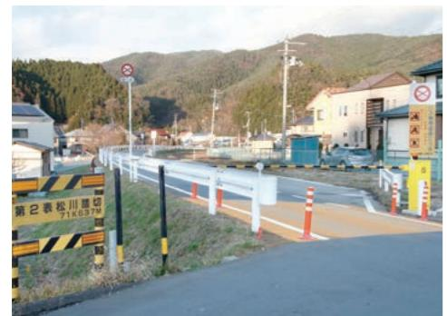
元は踏切だった箇所をBRTの専用道が走る。遮断器は専用道に設けられ、一般車両の誤進入を防いでいる。
