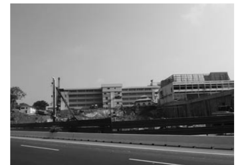
山留掘削・基礎工事 後方に見えるのが既存施設
