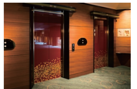
エレベーターの扉は、装飾の金箔を金沢で貼ったもの。開業当時から変わっていない。機械設備の部分は定期的に更新されるが、美しい仕上げは大切に引き継がれている。
