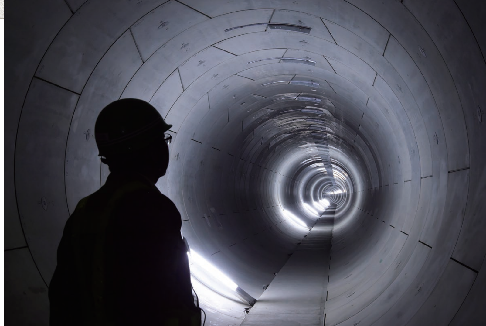
ほぼ完成した共同溝。ここに東京西部エリアの約25万軒分の電力と約70万の通信回線を供給するケーブルが敷設される。セグメントの施工にはミリ単位の精度が求められる。施工箇所を1カ所ごとに計測、確認を繰り返した。セグメントの数は全体で850リングを超えた。
