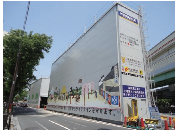
上/防音ハウス設置状況。手前側でバックホウが掘削土を集め、搬出されていた。壁面には新旧の街道風景を浮世絵風に表現した。 下/バックホウには壁と接近すると稼働を規制するセンサー付きの安全装置を装備した。(提供:株鴻池組)
