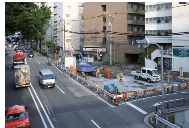
道路が分岐するほんのわずかな敷地に到達立坑があった。見学会の参加者からは、これほど小さな施設の下で大きな工事が行われているとは知らなかったという感想が相次いだ。
