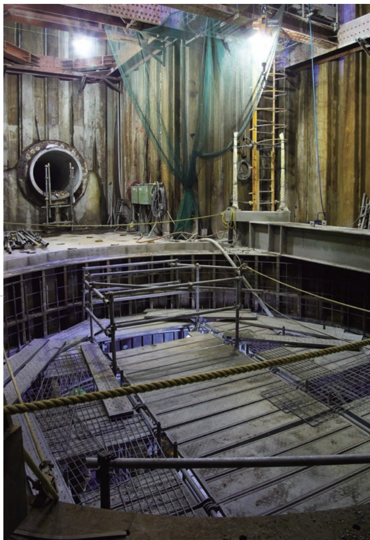
坑口は地上から10mほどが凸形。その下はアーバンリング工法により筒型の土留め壁が構築された。その部分にシールド機が切削到達。到達立坑だけで複数のNETIS(新技術情報提供システム)登録技術が駆使されている。
