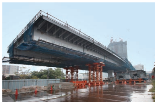
舗装工事を待つ高架。晴海を抜け、豊洲までつながる。将来的には豊洲新市場が開業し、物流ネットワークの重要な役割を担う。
