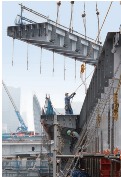
勝どき5丁目、6丁目付近の工事現場。「隅田川橋りょう（仮称）」につながる高架は、現在橋桁の施工が佳境を迎える。
