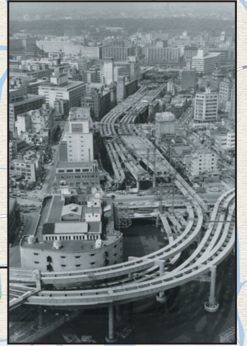
建設が進む首都高速道路
