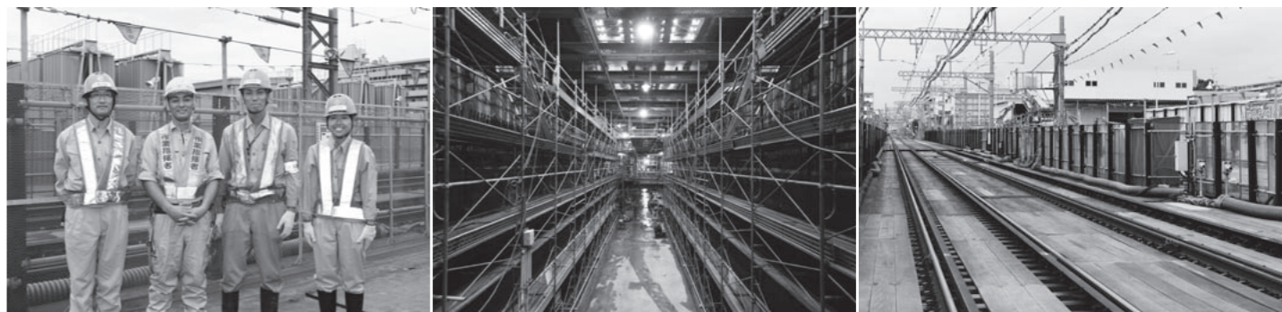
左/京急大師線連続立体交差の現場にて、的場猛所長(左)、小山大輔工事主任(右)と。インターンの学生も生き生きとしている。 中/既存の線路を桁化して、その下を掘削、躯体を構築する。この足場や土留め壁なども全て鳶・土工の仕事。 右/桁化された線路。この直下で、人知れず日々作業が続けられている。
