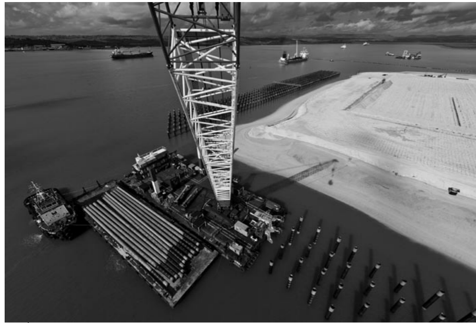
鋼管杭打設工
