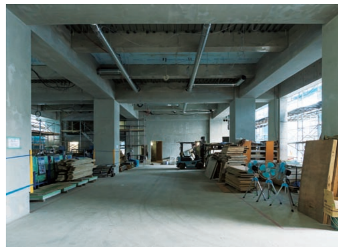
1階ピロティの様子。天井高は5mある。柱が大きいので、空間の大きさには違和感を覚えるほど。
