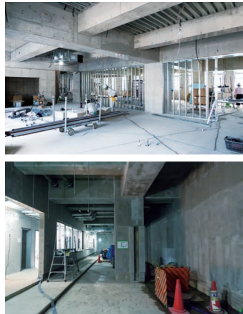
上/食堂及び仮眠室の建設風景。 下/地階に設けられている屋内訓練室。ここでは、放水訓練が行われる。
