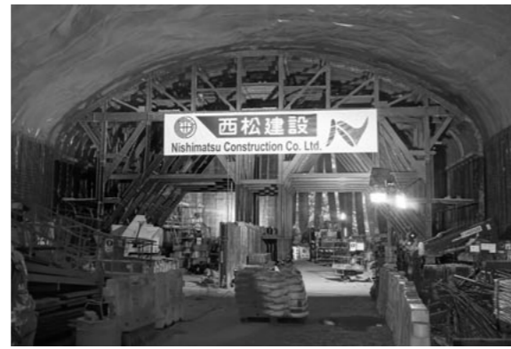
何文田駅カバードーム工用セントル
