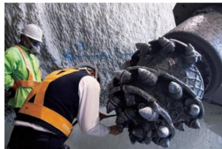
削孔は精度を高めるため自由断面掘削機により粗掘削と仕上げ掘削の2段階で行う。50年前のコンクリートは強靱だ。先端のカッタービットを何度も交換しながら掘り進めていく。
