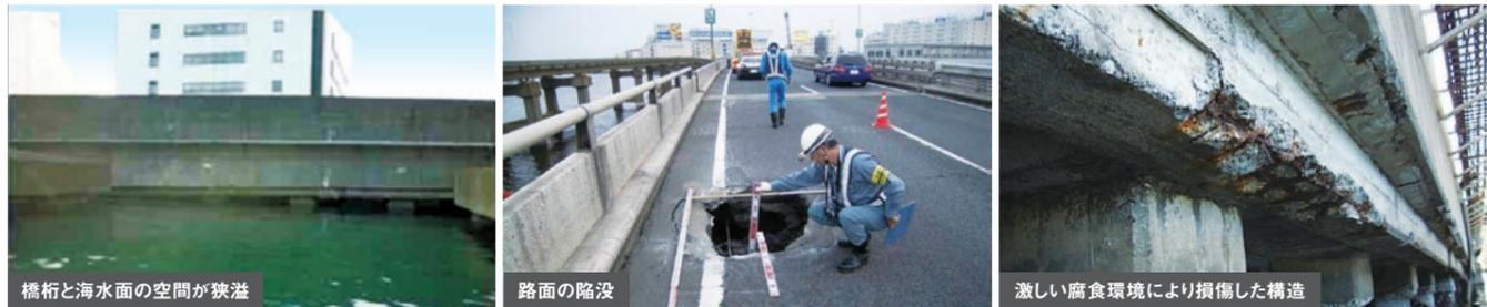
モノレールと並走する1号羽田線。海面との空間が狭く、激しい腐食環境等により構造物の損傷が進行している。鮫洲付近の埋立部では路面の陥没といった損傷も発生した。(下段写真提供：首都高速道路(株))
