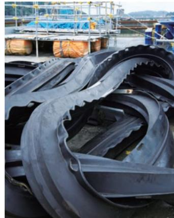
堤体と密着させるために浮体式締切堤に設置される止水ゴム。防波堤などの海洋構造物に用いられる「土木」の技術が導入された。
