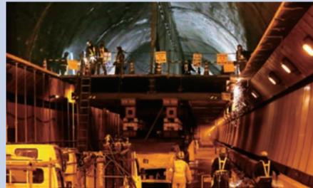
5×1.2m、1,200kgほどの天井コンクリート板がV字型に崩落した。その数およそ270枚、138mにおよぶ崩落箇所3台の車が巻き込まれた。笹子トンネルの開通は昭和52年。NEXCO中日本は事故の主原因として施設の老朽化をあげている。写真は、事故から1カ月がたち、天井板の撤去作業が行われている笹子トンネル。(提供：毎日新聞社)
