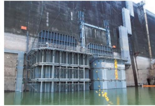
浮体式のブロックは、本体を鋼板で被覆し、内部に気密室を設けて扉体を浮体化する。左側が台座式、右側が浮体式の締切堤。現場の状況に応じて解体せずに転用することも可能だ。(提供：鹿島建設(株))
