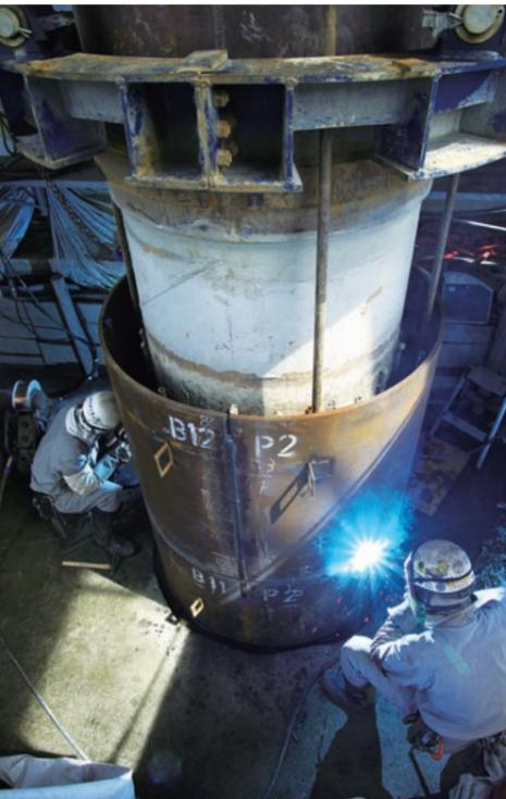
円筒を縦に2分割して工場製作された補強鋼板を現場の既存杭に巻き立てる。溶接して茶筒状になった鋼板を順次地中に圧入する。
