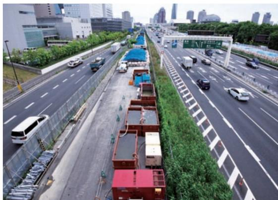
施工ヤードは高速道路に沿うように展開せざるを得ない。圧入で発生した泥水の濁水プラントもコンパクトに配置されている。
