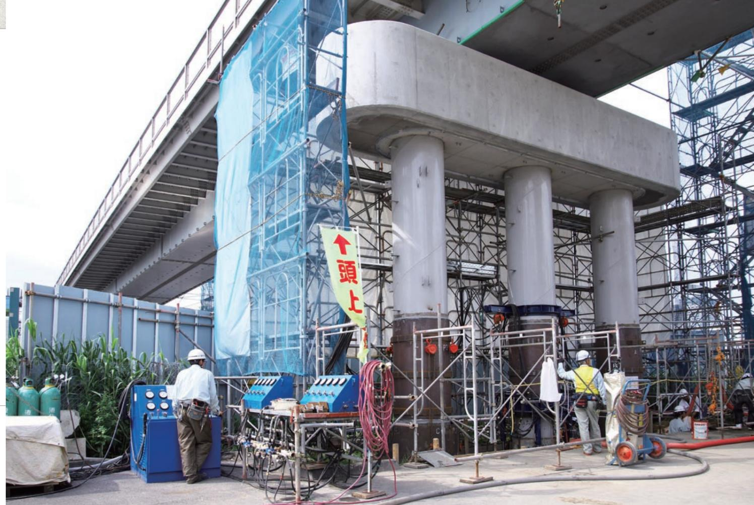
全長140mを超えるコロシアムブリッジの3基の橋脚を耐震補強する。直下には首都高、国道が走る。幹線道路と近接する現場に求められるのは高精度の施工と万全の安全対策だ。
