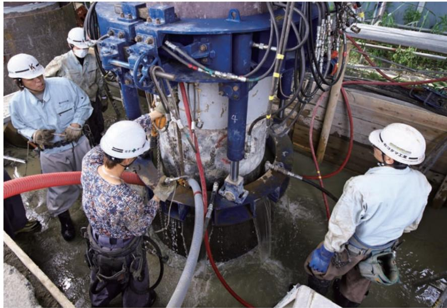
既設杭にガッチリと固定された圧入装置が補強鋼板を地中に押し込んでいく。周囲の地盤に及ぼす影響も最小限に抑える。
