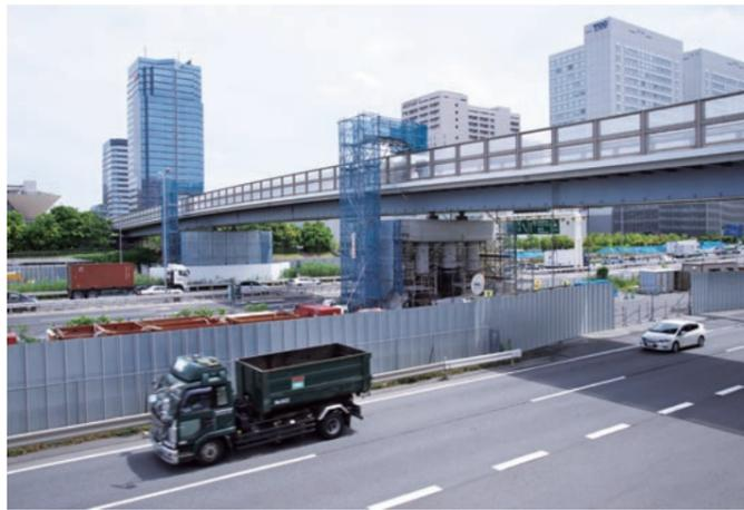
都内における橋梁の耐震計画は橋桁など地上部の補強が終了しつつある。今後、地下構造の強靱化が本格化するなか、コロシアムブリッジの橋脚耐震補強に採用された「SSP工法」が有望なソリューションとして注目を集めている。
