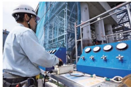
補強鋼板の最終圧入はミリ単位で計測しながら行う。携わるスタッフの「あーん」の呼吸が高精度施工の要だ。
