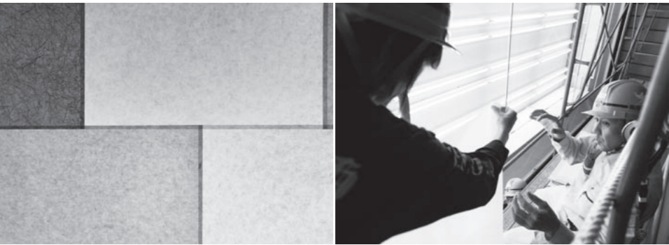
左／「重ね10mm、誤差1mm以内」という厳しい仕様に基づき、糊や温度・湿度の影響を受けやすい3種類の和紙をその変化も計算して貼りあげた。 右／高所での作業、一枚は約60cm×90cmの大きさがあるため、二人で呼吸を合わせて貼っていく。
