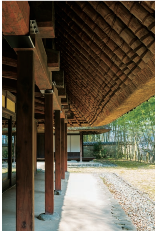
主屋の窓から軒先まで約4mの深さ。茅葺きの茅はススキが、屋根を支えるタルキには耐久性の高いヒノキが使われている。
