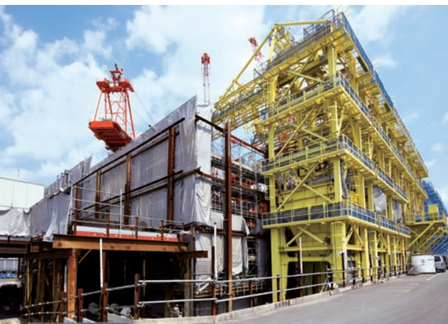
限られた敷地を最大限に活用するために重層的な構造となった現場。足場は複雑に入り組み、立体迷路のようだ。左奥に作業員たちの休憩所がある。
