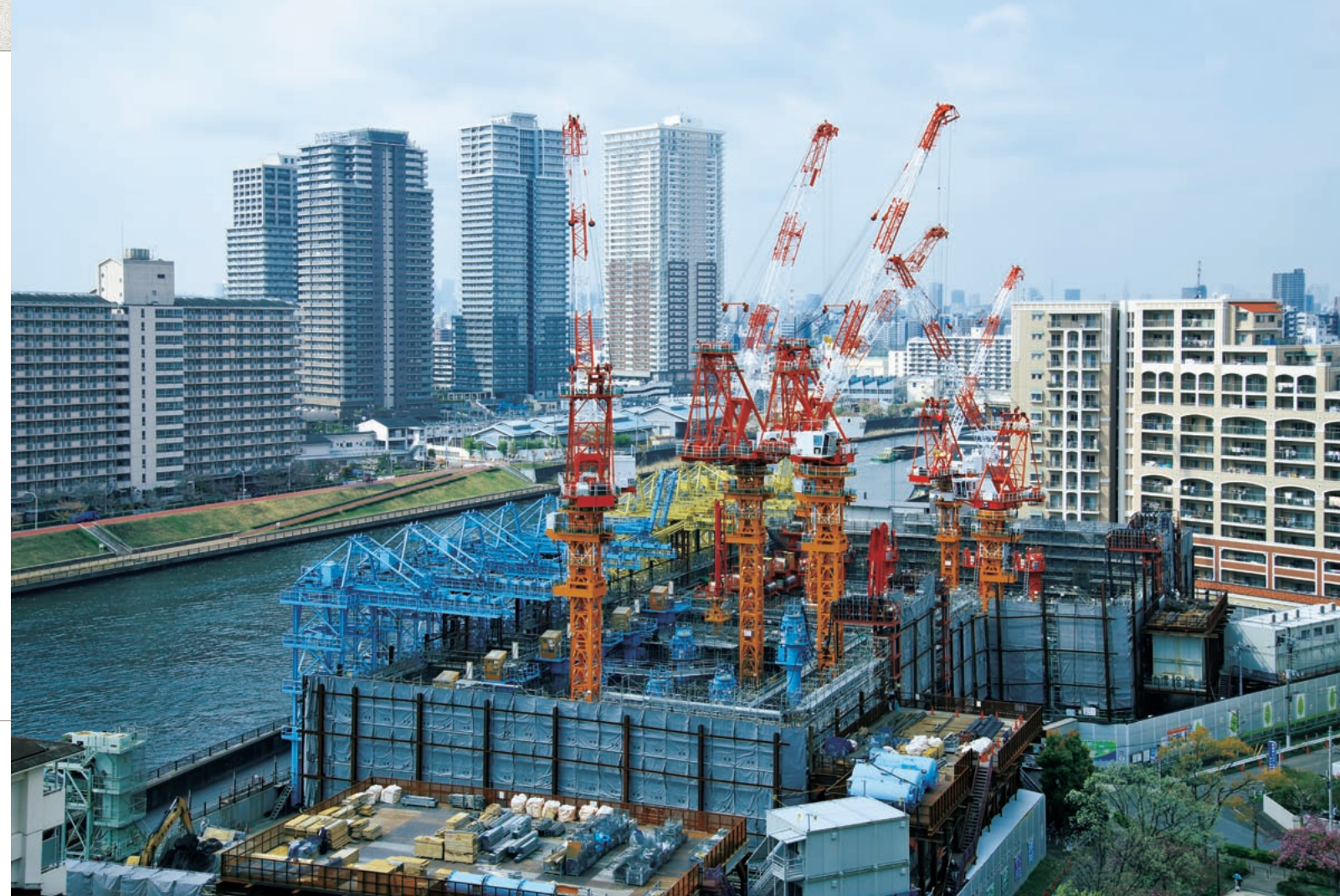
周囲を高層マンションに囲まれた土地でポンプ所の建設が進む。観客席に囲まれたコロシウムのような現場だ。周辺の住環境保全が最大の課題となる。
