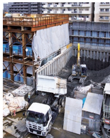
掘削された土は作業室から運び出される。ベルトコンベアーに乗って、隅田川で待つ船へ移動、搬出される。
