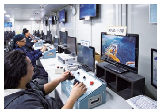
上／天井部から吊り下がる地下作業室の掘削重機。深度20m以浅は潜函工が乗り込み作業を行うが、それ以降は無人工化施工（遠隔操作）に切り替える。（提供：株大林組） 下／地上の掘削管理室。掘削重機を直接操作していた潜函工がスティックを操る。モニターは1cm単位の高精度で表示される。
