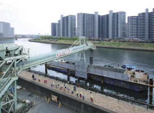
掘削土をすべて船で搬出することも周辺地域への配慮の一つ。地域との信頼関係が、住宅地の中心で進む大きな現場の安全と安心を支えている。
