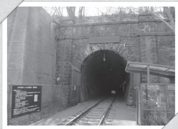
大日影トンネル遊歩道 勝沼側の入口
